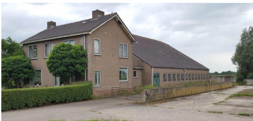
Afbeelding 6: Aanzicht perceel Vlietskade 80-82 Gorinchem
