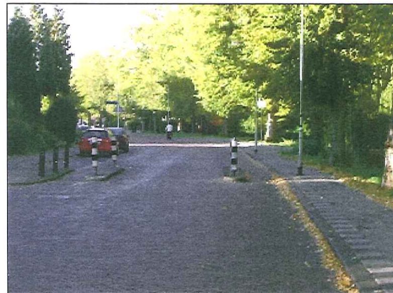
Foto 8: huidige wegversmallingen (sluisjes) met smalle fietspasseerstrook
