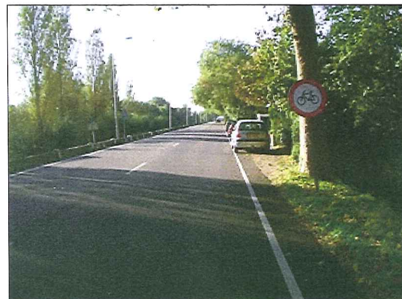
Foto 4: Arkelsedijk met betonnen keerwand en geparkeerde auto
