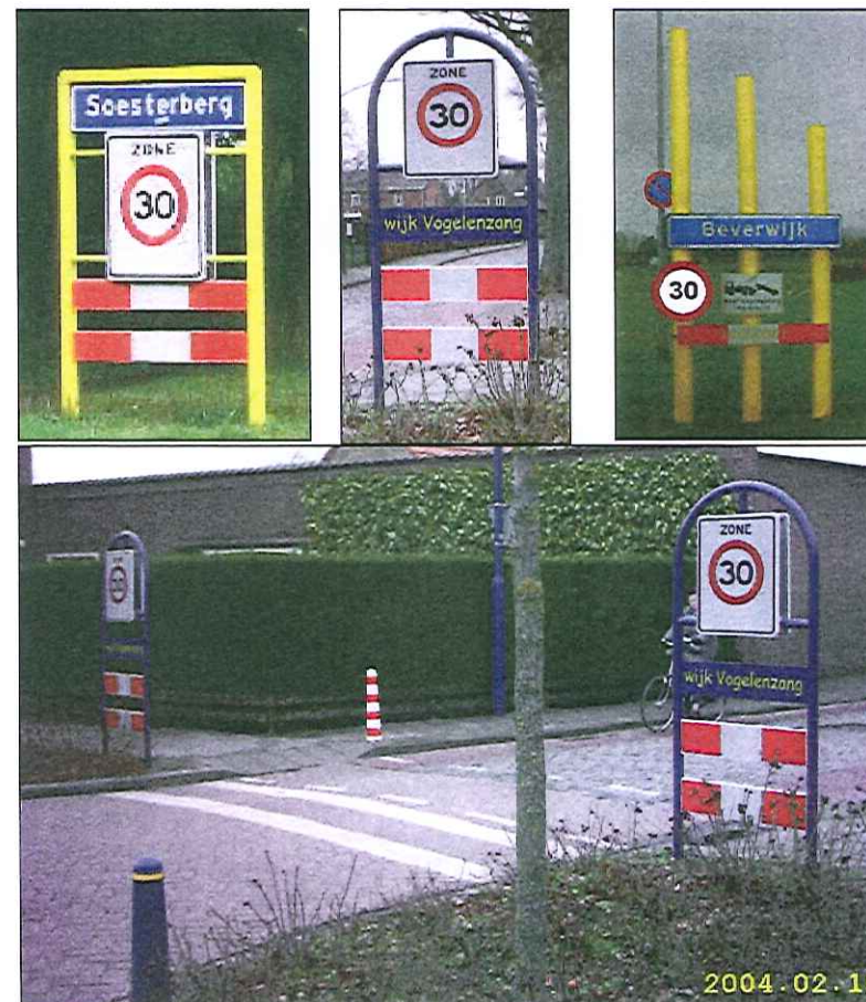
Foto 7: voorbeelden poortconstructies 30 km/h-zone
