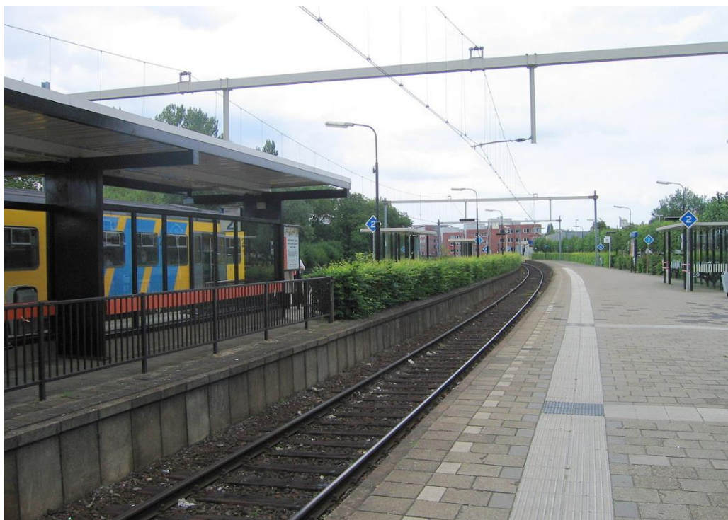
Foto van de perrons, genomen in oostelijke richting
