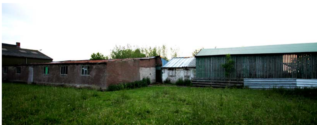
Achterzijde stallen en hooiberg.
