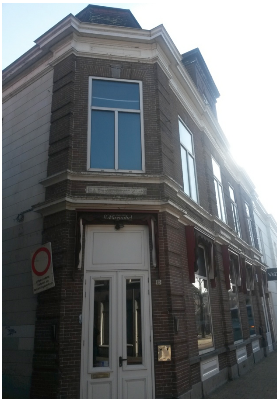
Figuur 1 Foto te renoveren hoekpand
