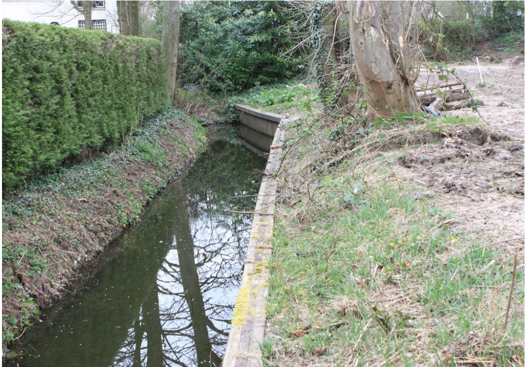
Slootkant met steile oever en hardhouten beschoeiing.
