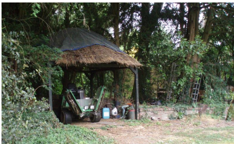
Prieel als onderdeel van de lage keermuur als omzoming van het gazon. Foto: SB4, 2011.
