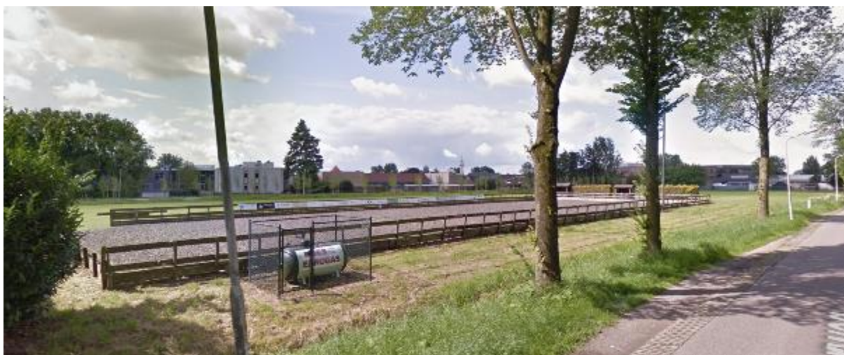
Figuur 2.1: Plangebied vanuit het zuidoosten (boven) en het noordoosten (onder)
