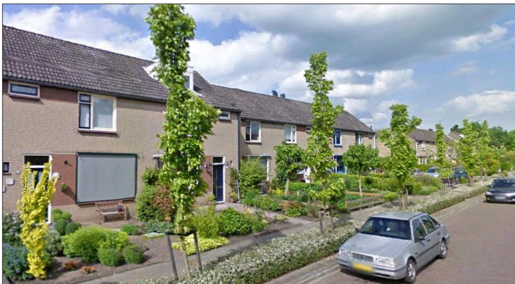
Typerende bebouwing voor de wijk Stalkaarsen (rijwoningen met verspringende gevel per blok)
