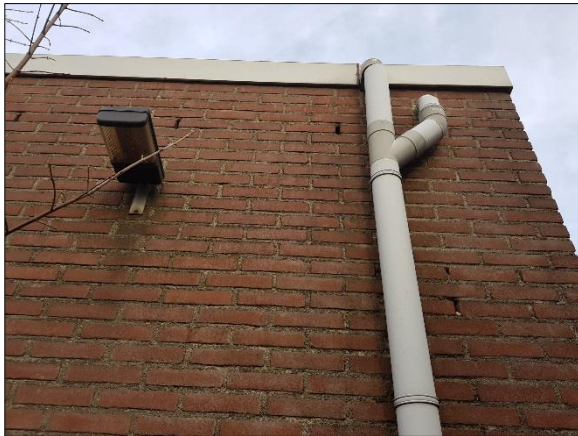
Figuur 13. Open stootvoegen in de Schoenenreus
