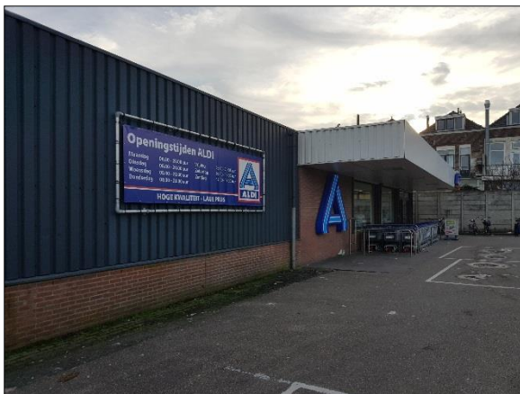
Figuur 3. Ingang gebouw Aldi
