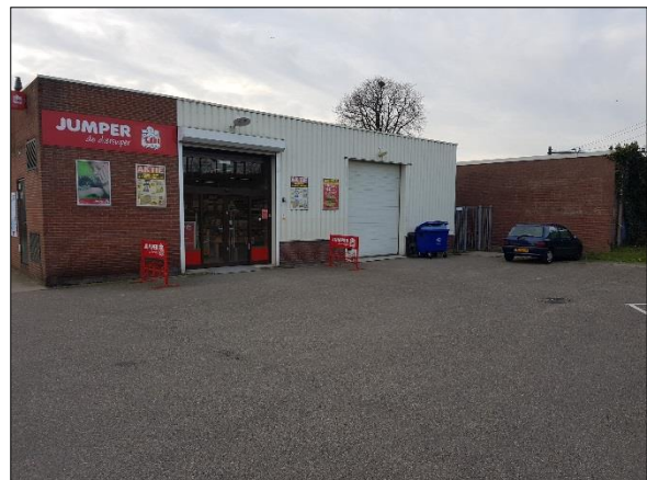
Figuur 4. Ingang gebouw Jumper
