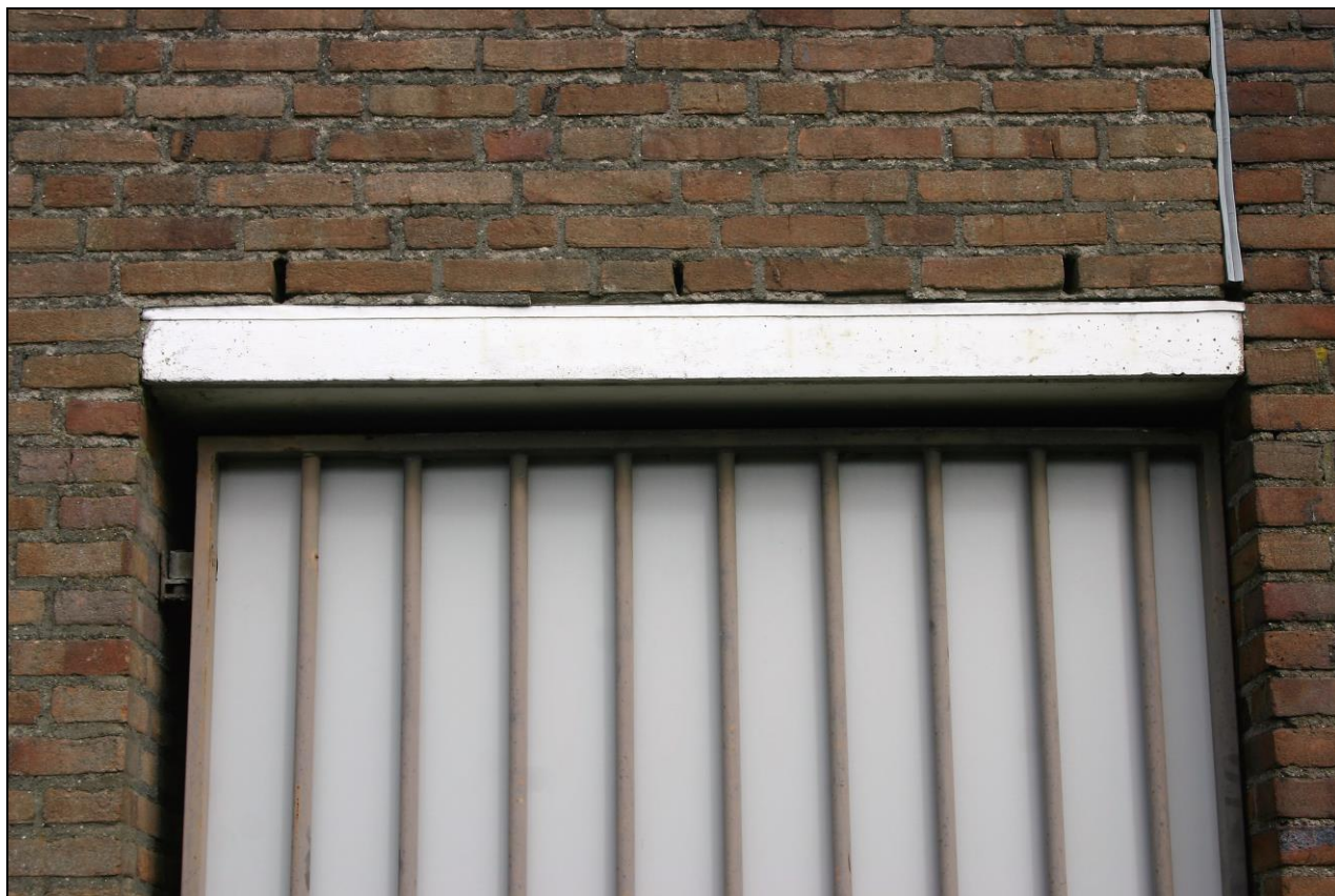
Figuur 4.5.2. Open stootvoegen boven de deur van de lage aanbouw.
