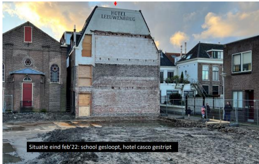
Figuur 2-5 Situatie februari 2022, oud schoolgebouw gesloopt en hotel casco gestript
