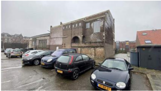
Figuur 4-7 Achtergevel in de huidige situatie
