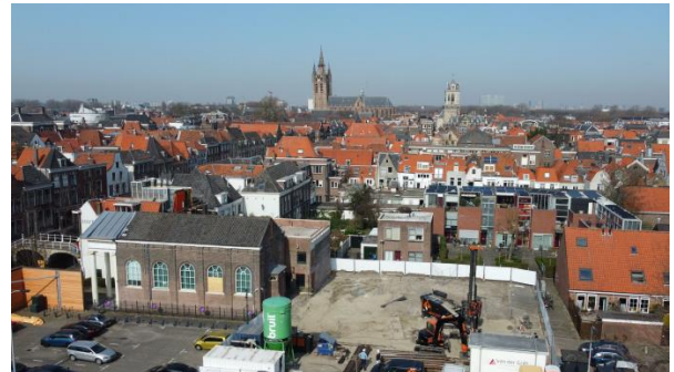
Figuur 2-6 Situatie maart 2022: fundering geplaatst, oud schoolgebouw gesloopt en bovenste 2 etages van hotelgebouw verwijderd
