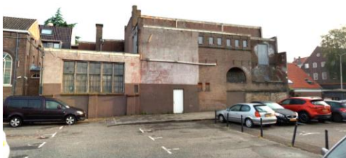
Figuur 2-3 Zuidzijde voormalig schoolgebouw (inmiddels gesloopt)
