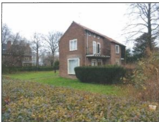
Afbeelding: de projectlocatie aan de Oostsingel 181, te Delft.
