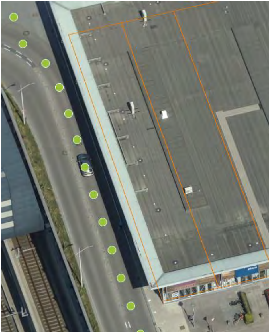
Figuur 4: Luchtfoto Roobol vanaf zuiden
