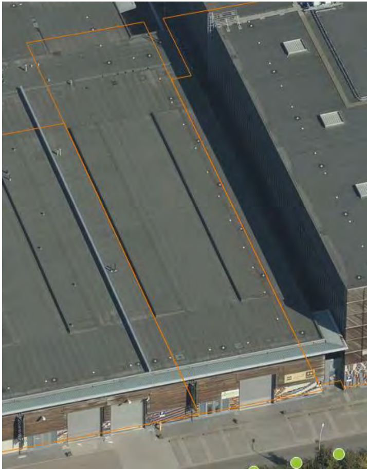
Figuur 4: Luchtfoto achtergevel Haco
