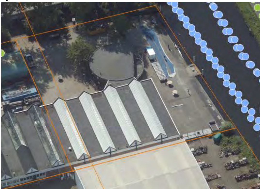
Figuur 6: Luchtfoto van Proteus-Eretes vanaf het noorden
