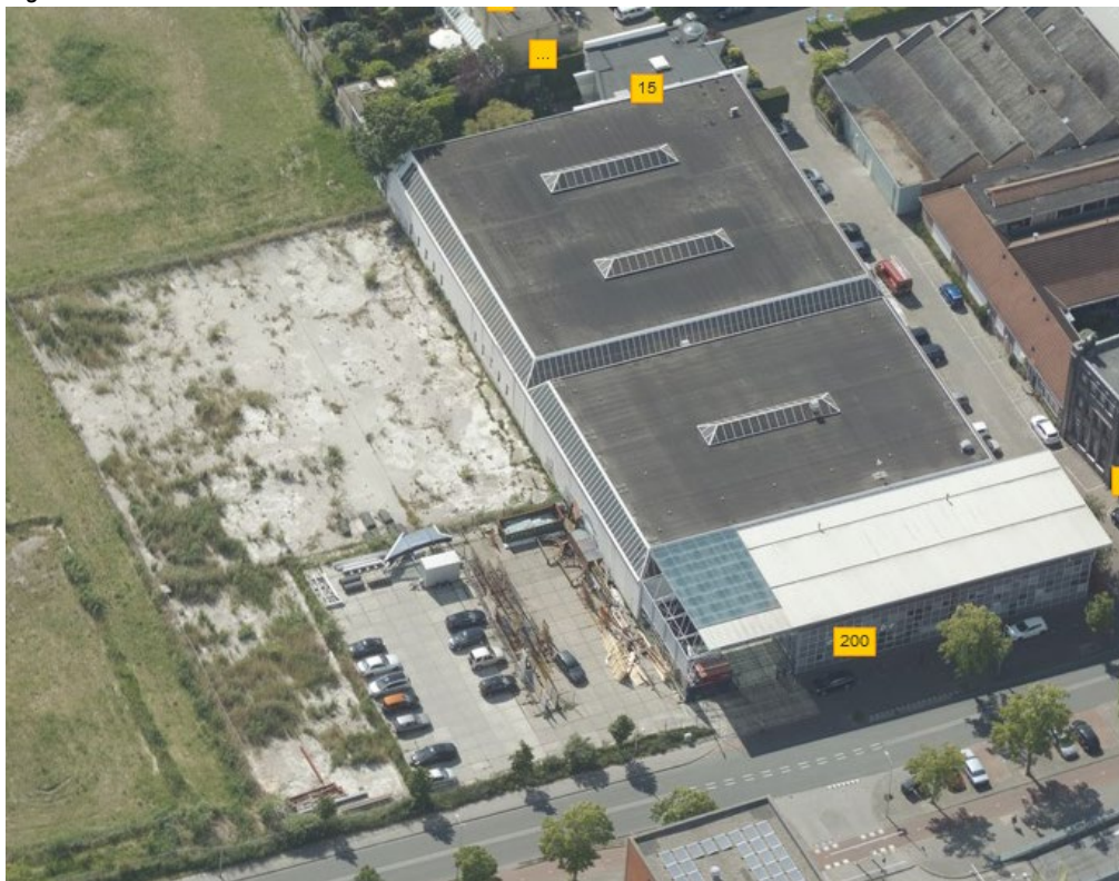
Figuur 4: Luchtfoto Octatube vanaf het oosten
