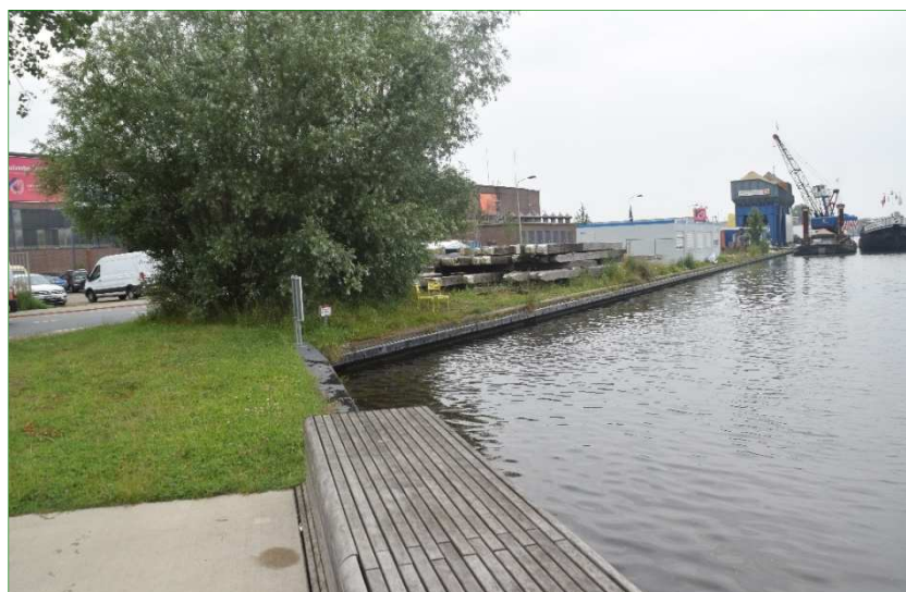
Beschoeiing van de kade langs de Schie.
