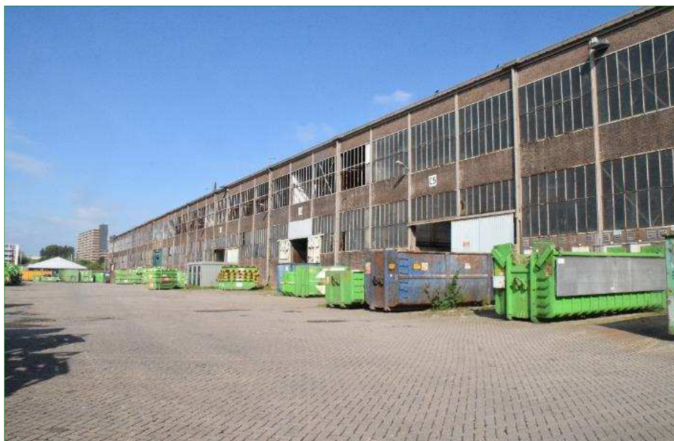
Hallen C1 t/m C8 van de voormalige Nederlandse Kabel Fabriek (NKF).
