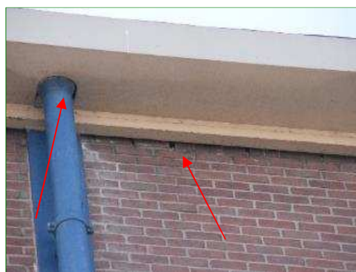
Open stootvoegen en kieren geven vleermuizen toegang tot geschikte ruimten.
