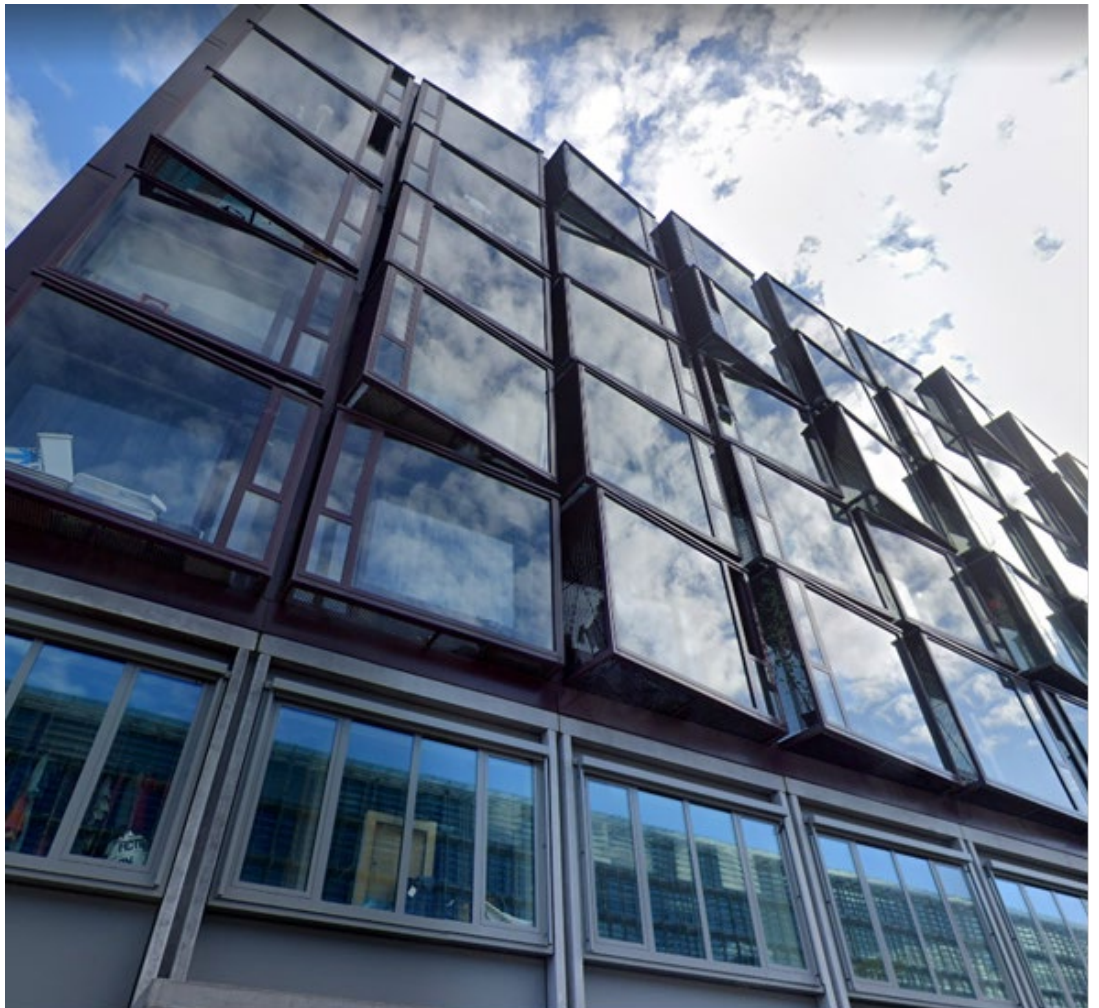
Kraanspoor bij NDSM: Hybride, vliesgevel, met eigen te openen deel, een zijde van de verglazingen is open.
