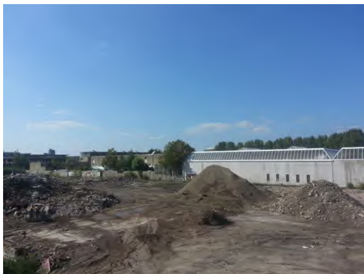
foto 6: afvoer puin afkomstig van funderingen
