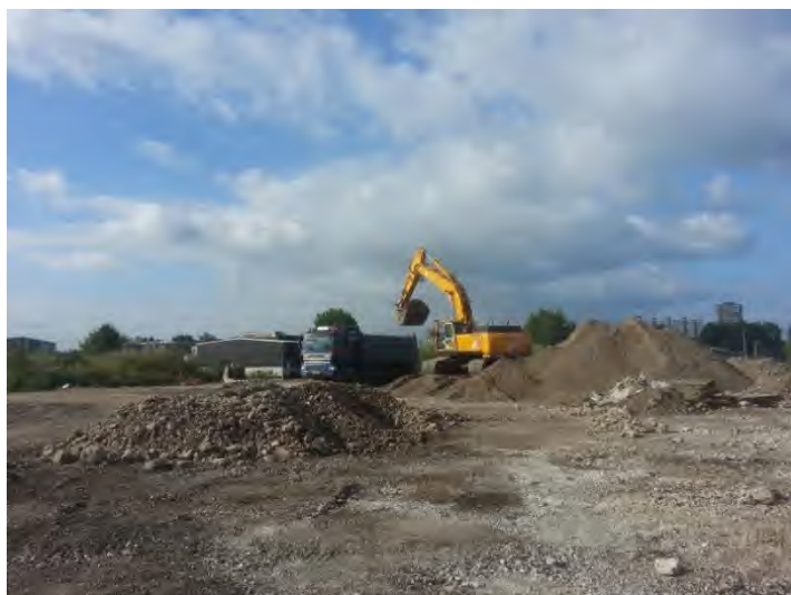
foto 5: afvoer puin afkomstig van funderingen
