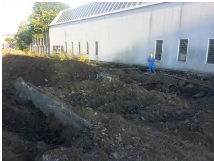
foto 4: ondergrondse sloop funderingen
