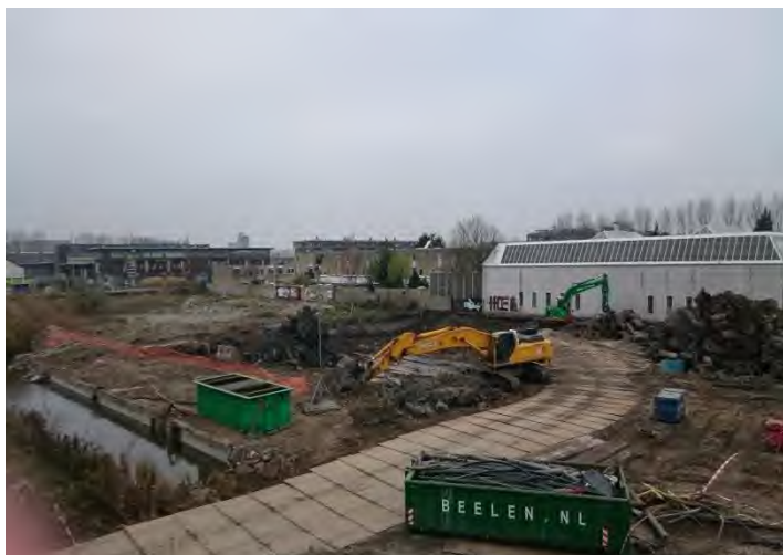
foto 7: verwijderen ondergrondse kelderbakken
