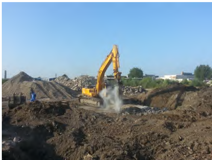
foto 2: ondergrondse sloop funderingen
