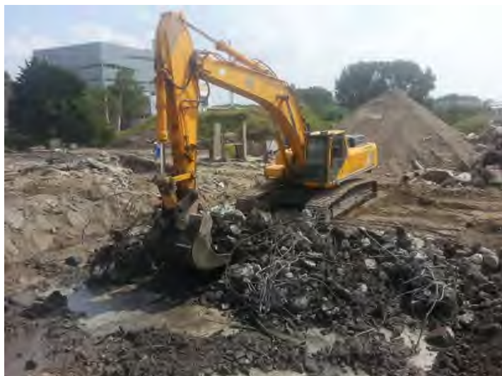
foto 3: ondergrondse sloop funderingen
