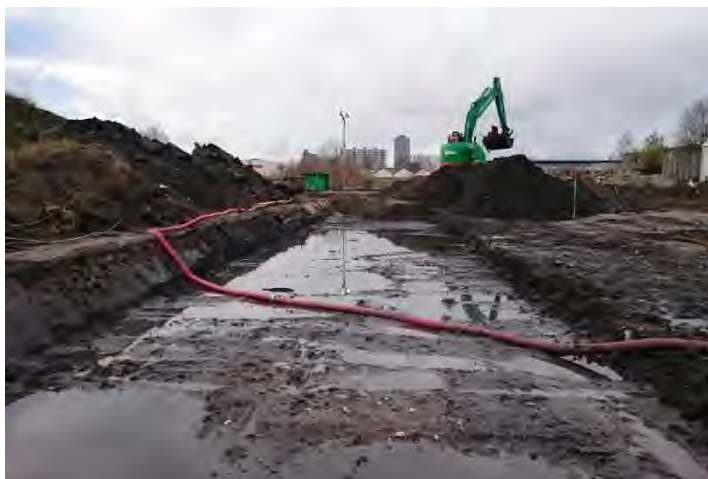
foto 15: ontgraven riool- / wegcunet
