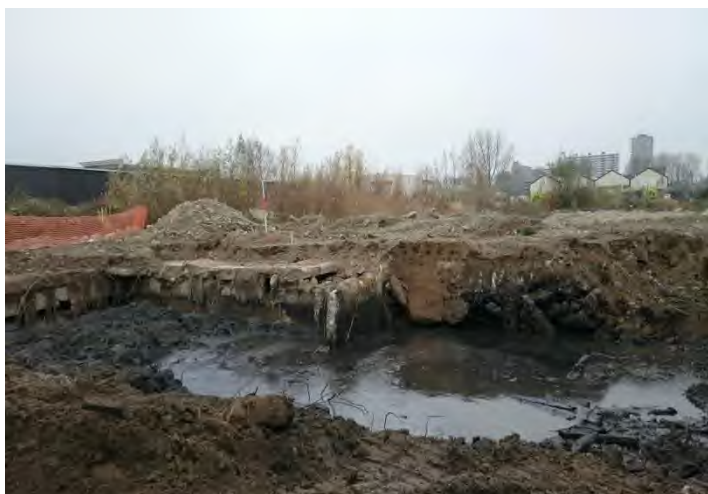
foto 9: verwijderen ondergrondse kelderbakken
