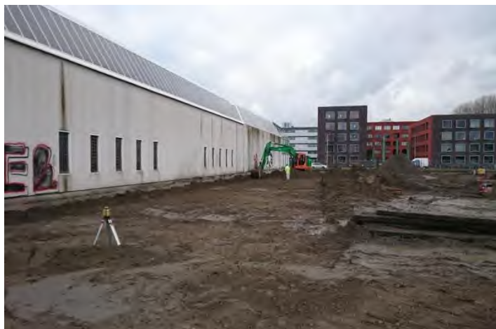
foto 14: aanbrengen leeflaag / opbouwlaag duurzame afdeklaag
