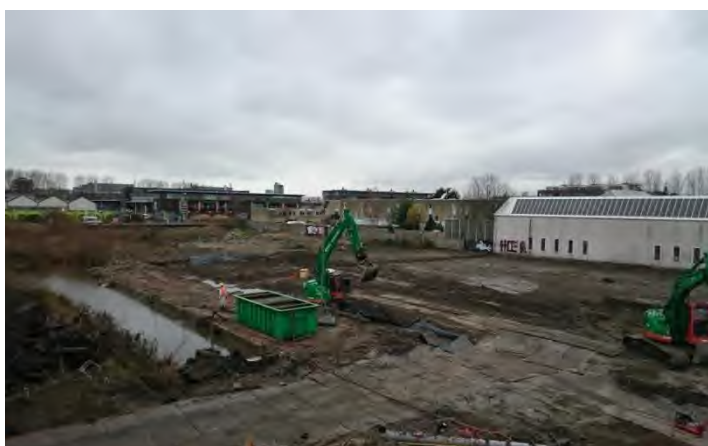
foto 17: afgewerkte leeflaag en opbouwlaag duurzame afdeklaag
