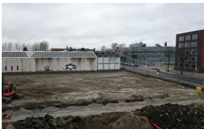
foto 18: afgewerkte opbouwlaag duurzame afdeklaag en riool - wegcunet
