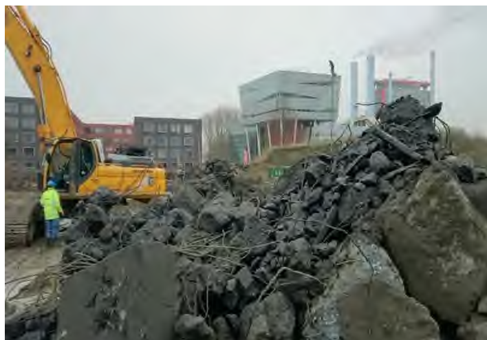
foto 10: verwijderen ondergrondse kelderbakken
