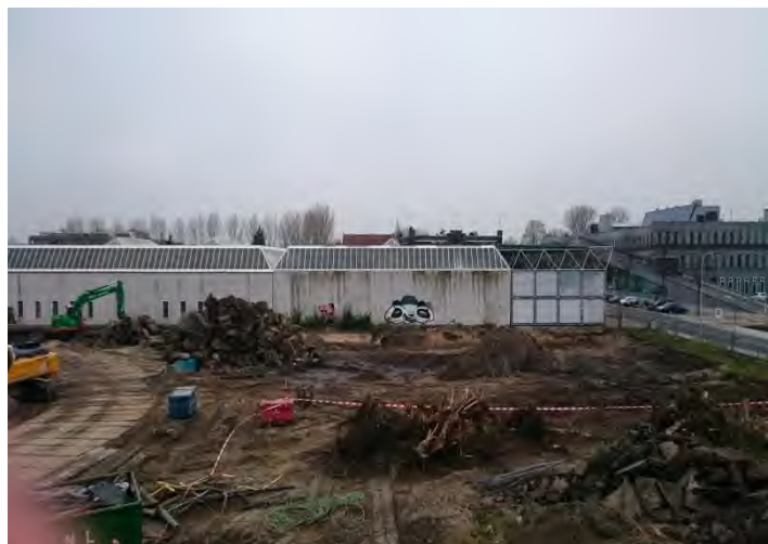
foto 8: verwijderen ondergrondse kelderbakken
