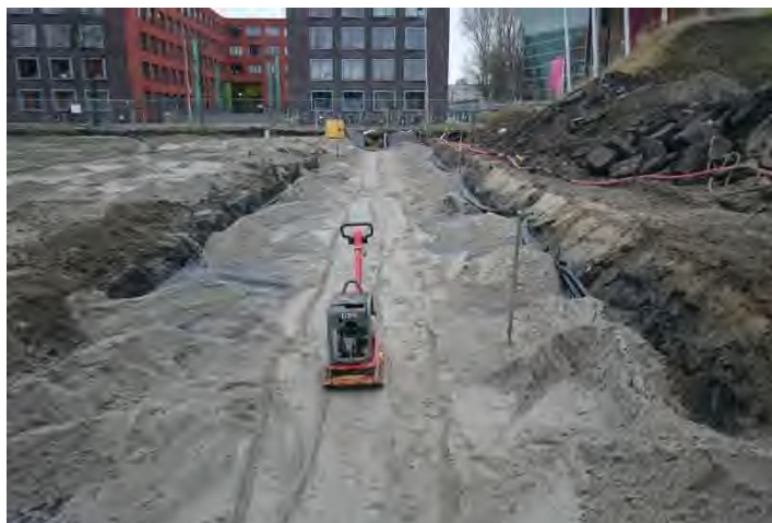
foto 16: aanbrengen schoonzand riool- / wegcunet
