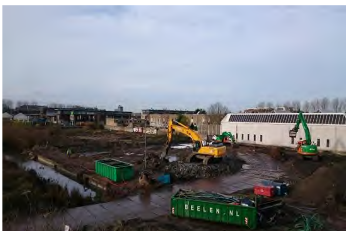
foto 11: afvoer puin afkomstig van kelderbakken
