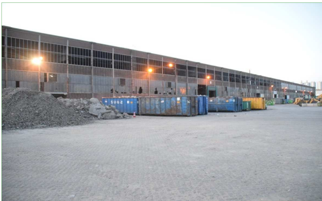
Gedeelte van het kabeldistrict dat ook volledig kon worden bekeken tijdens het onderzoek van het Suez gebouw.
