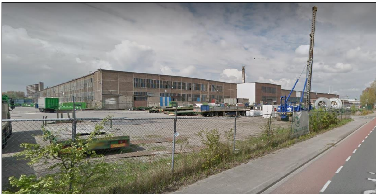
Figuur 15. De huidige fabriekshallen gezien vanaf de Schieweg (Bron: Google Maps).
