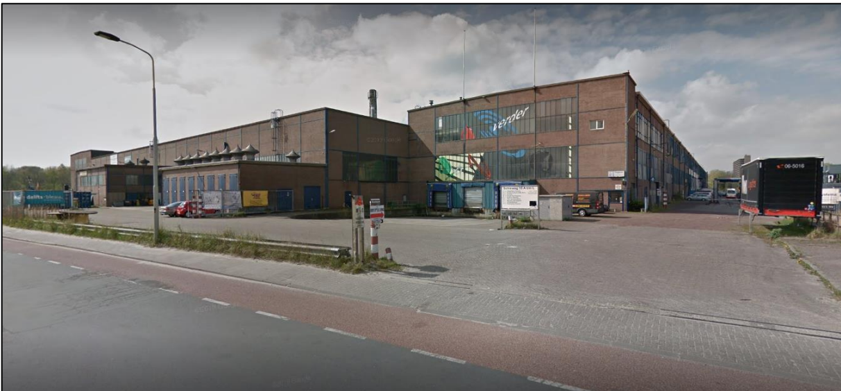
Figuur 14. De huidige fabriekshallen gezien vanaf de Schieweg (Bron: Google Maps).
