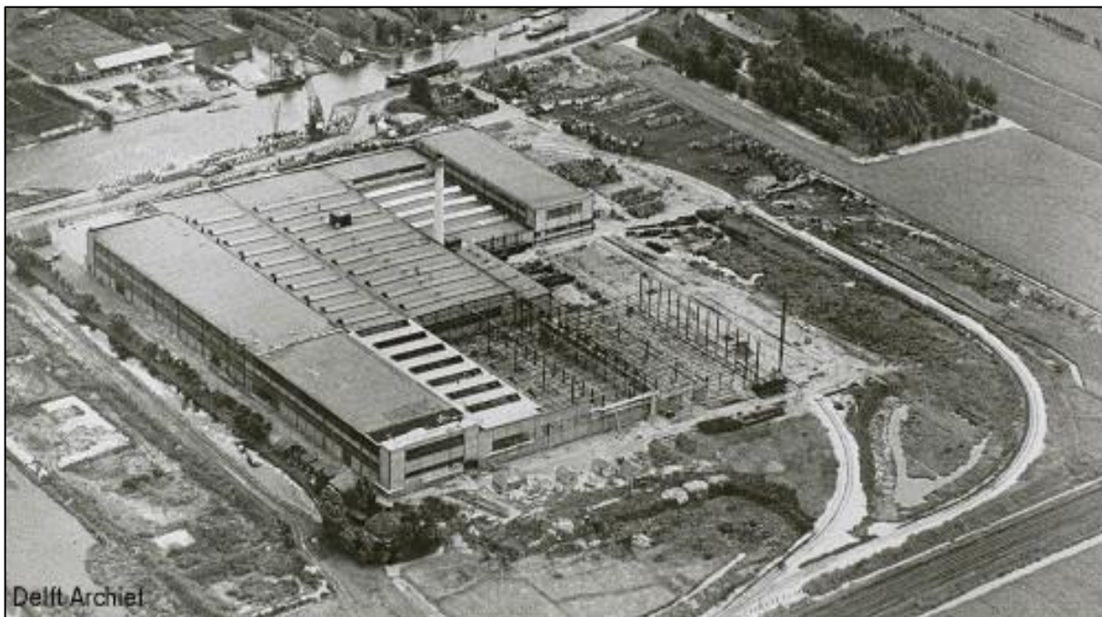
Figuur 6. Bouwwerkzaamheden van fabriek II in 1951 (Bron: Gemeentearchief Delft).
