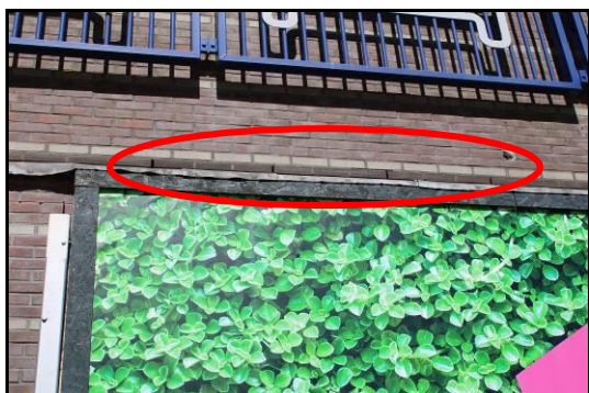
Afbeelding 5: Openingen bij stootvoegen
