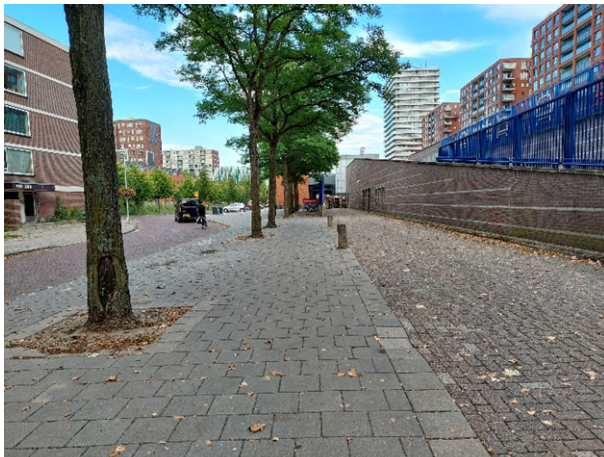
Fotonummer: 9 Omschrijving: Trottoir en ingang parkeergarage langs de Troelstralaan ter plaatse van deellocatie 1.
