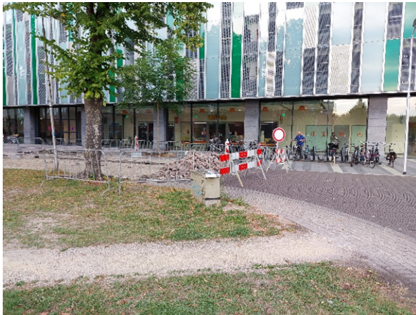
Fotonummer: 1 Omschrijving: Wegopbreking nabij deellocatie 2
