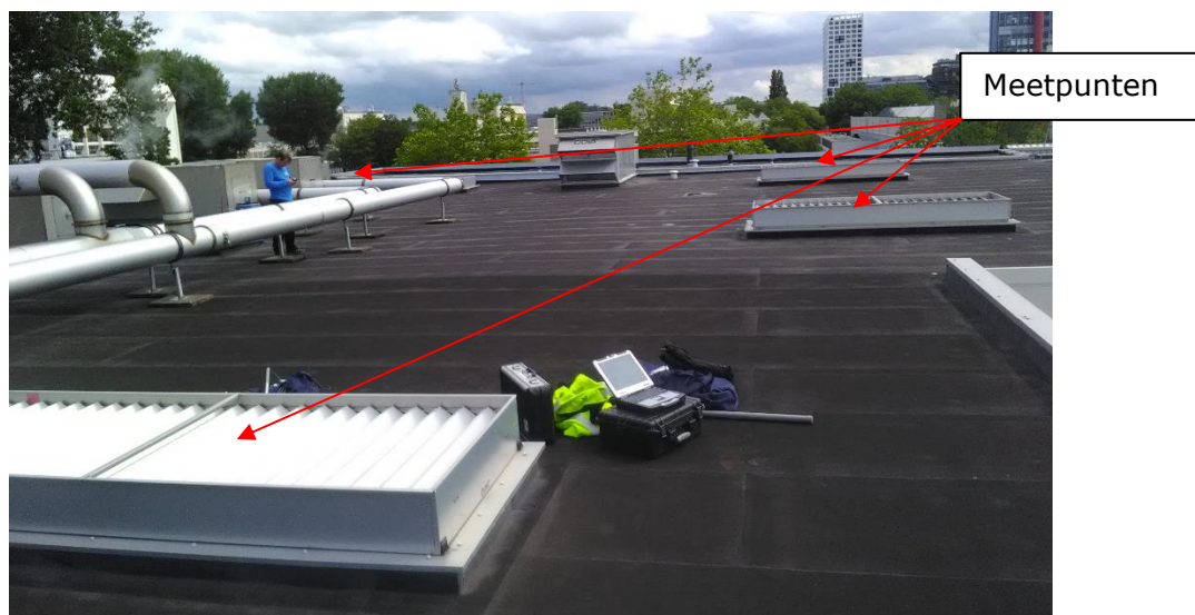
Figuur 2.2 Meetsituatie van ventilatie hal oost
