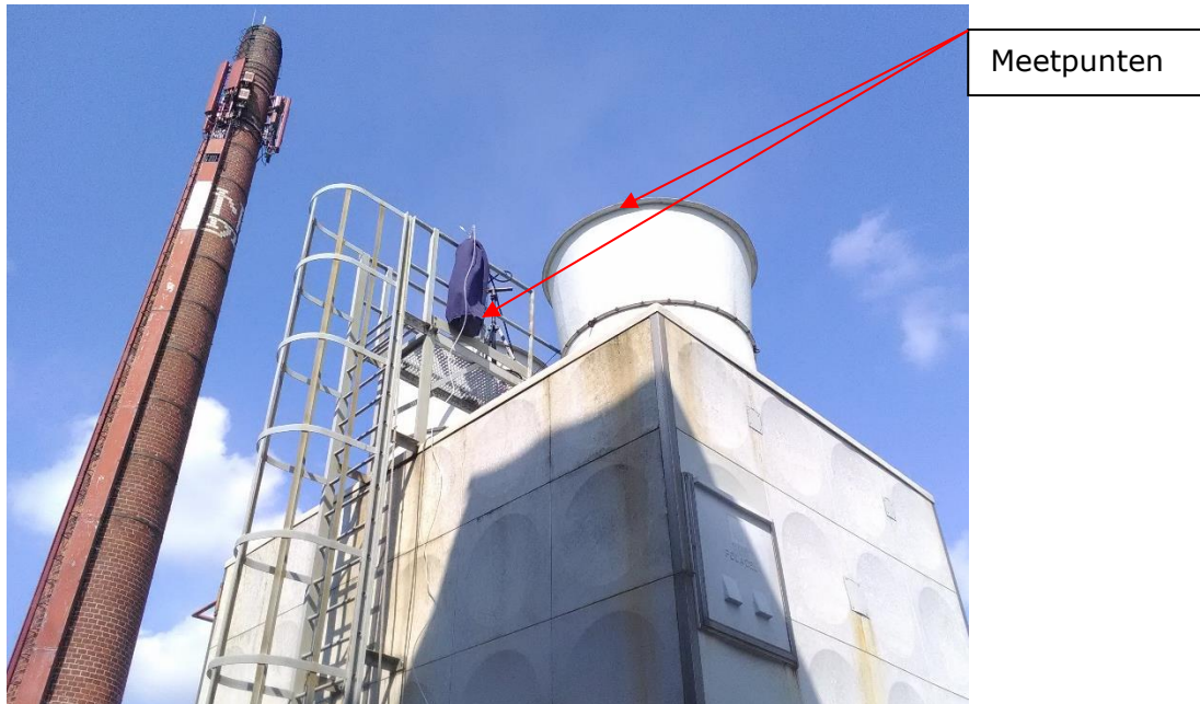
Figuur 2.4 Meetsituatie bij de koeltoren
