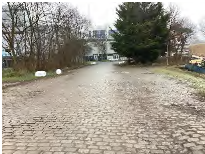
foto 4: De Nieuwe Haven gesloten terrein aanzicht noordzijde
