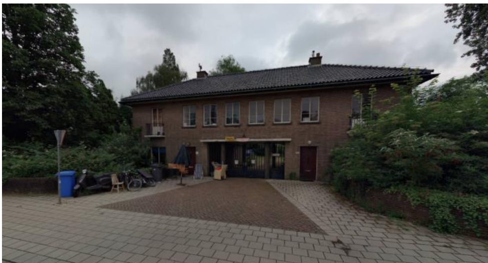
Figuur 4.3 – Huidige uitgang van Gele Scheikunde aan de Julianalaan. Door de poort kunnen geen hogere voertuigen rijden en auto's kunnen elkaar ook niet passeren, daarom is een in/uitgang van het terrein aan noordzijde van dit poortgebouw gepland.
