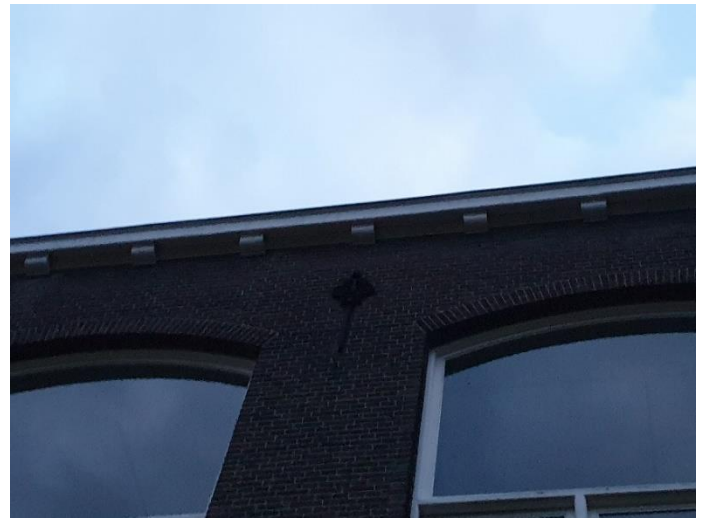
Figuur 3. Locatie van een aantikkende gewone dwergvleermuis bij de daklijst aan de noordzijde van het gebouw bij de parkeerplaatsen aan de westelijke kant.
