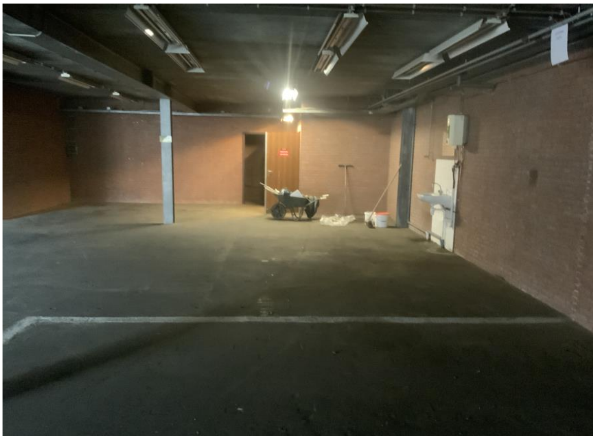
Foto 2: Inpandig oostelijke gebouw in oostelijke richting
