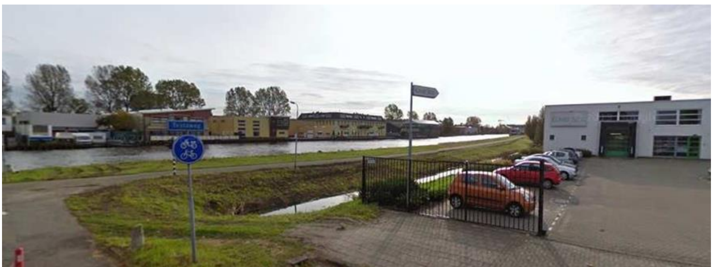
Figuur 7 Zicht westoever Delftse Schie vanaf Marconiweg, richting zuiden (Bron: google maps)
