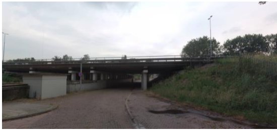
Figuur 7-8 Onderdoorgang A13
