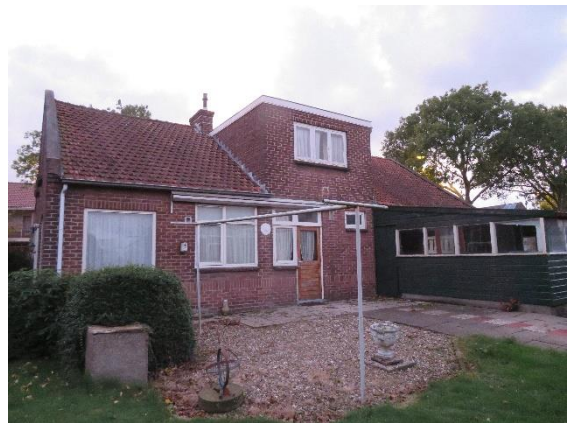
Fig. 1. Achterzijde locatie met zicht op de te slopen gebouwen
