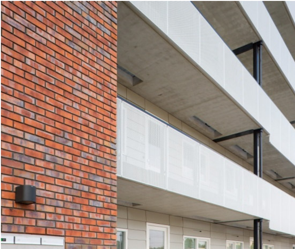
Foto 6: Spoorzone Amersfoort. Verhoogde boegdelen en het gebruik van absorberende materialen waardoor de gevel niet doof hoeft te worden uitgevoerd
