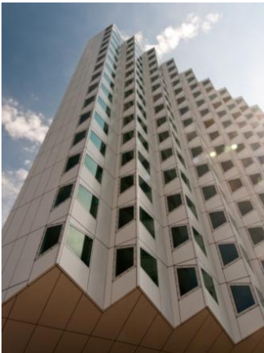
Foto 1: Zaagtand gevel vanwege het geluid van de N470, Balthasar van der Polweg 3, Delft
