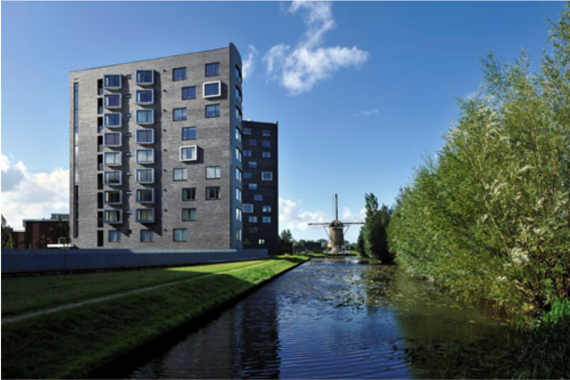
Foto 4: Leliepark in Gouda. Gecombineerde gevelopbouw met erkers, loggia's (in pandige balkons) en dove geveldelen gecombineerd.
