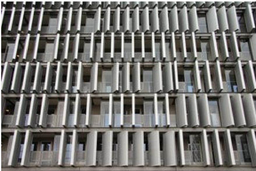
Foto 7: Laan van Spartaan Amsterdam. Lamellen zorgen voor voldoende afscherming om de achterliggende gevel niet doof te hoeven uitvoeren.
