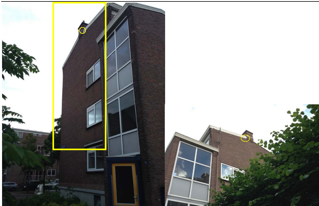
Figuur 2.2 Locaties van verblijfplaatsen aan de Van Schuijlenburgstraat: zomer- en paarverblijfplaats (achter de dakrandbetimmering) bij huisnummer 20-B (rechts), en (links) de kraamkolonie (via dakrandbetimmering in spouwmuur of dakconstructie) bij huisnummer 2-I (onder) waar ook de paarverblijfplaats aanwezig is ergens in de gevel (links).
