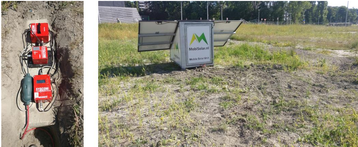
Afbeelding 3.4 Syscom trillingmeters geplaatst op ribben tunneldak (links) zonnepaneel op veld (rechts)
