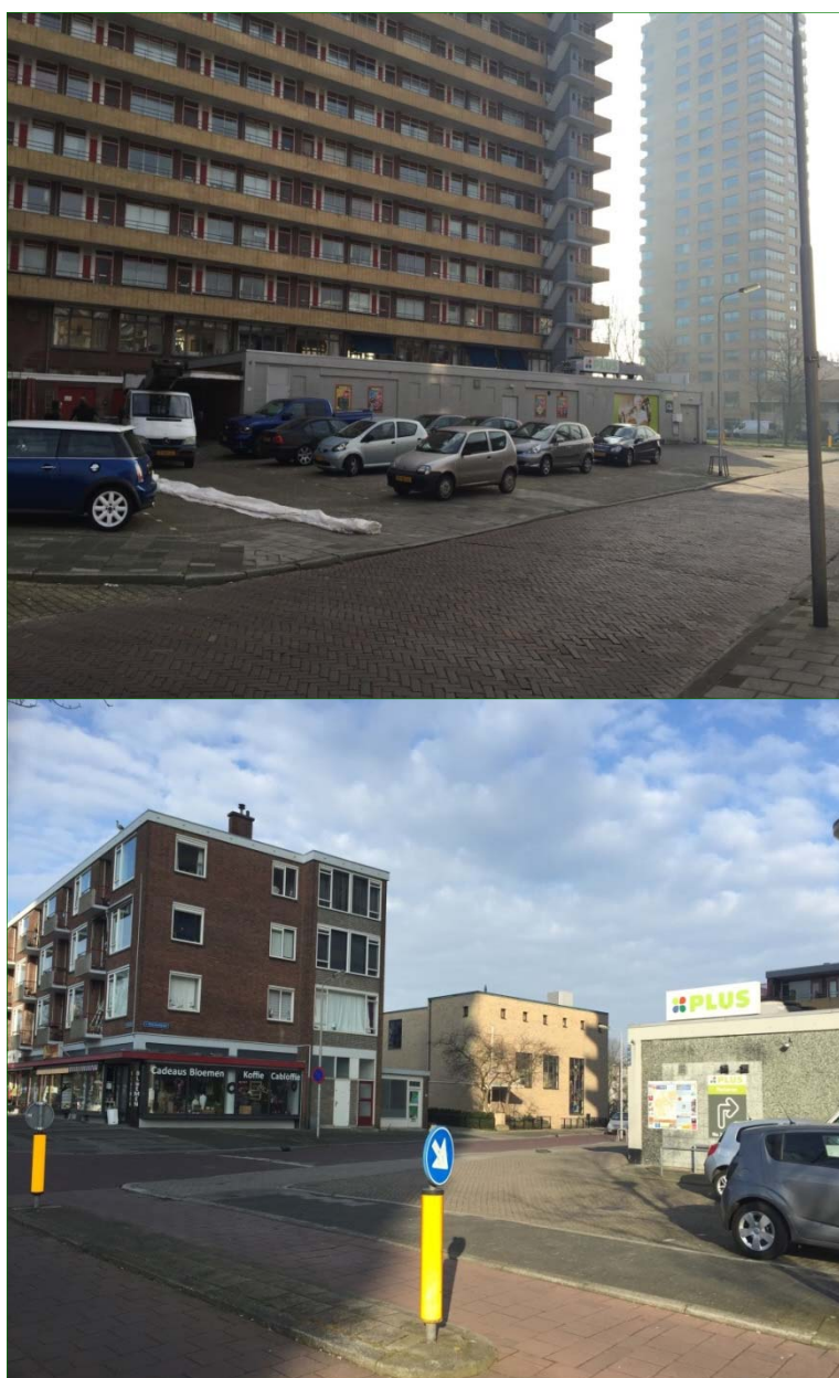
Huidige situatie waar Plus wil uitbreiden vanaf de noordwest (boven) en de zuidoostkant (onder) gezien.
