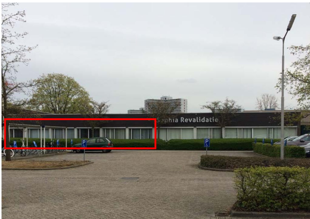
Figuur 3.10 Foto gevelaanzicht
