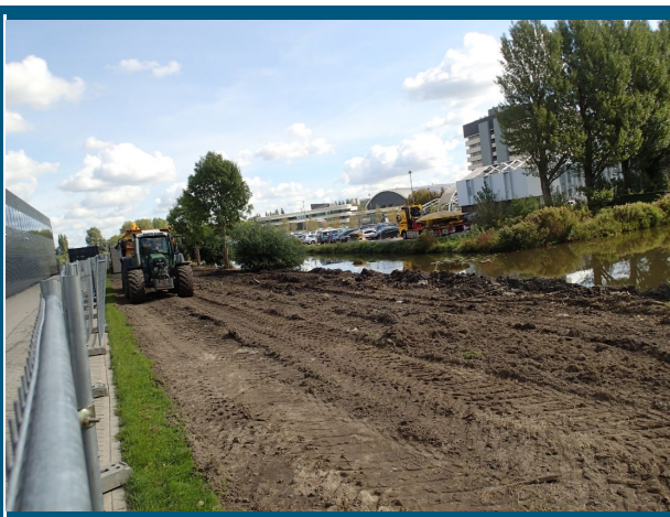
Foto 2.2. Aanleg natuurvriendelijke oever langs bestaande bebouwing in het plangebied.
