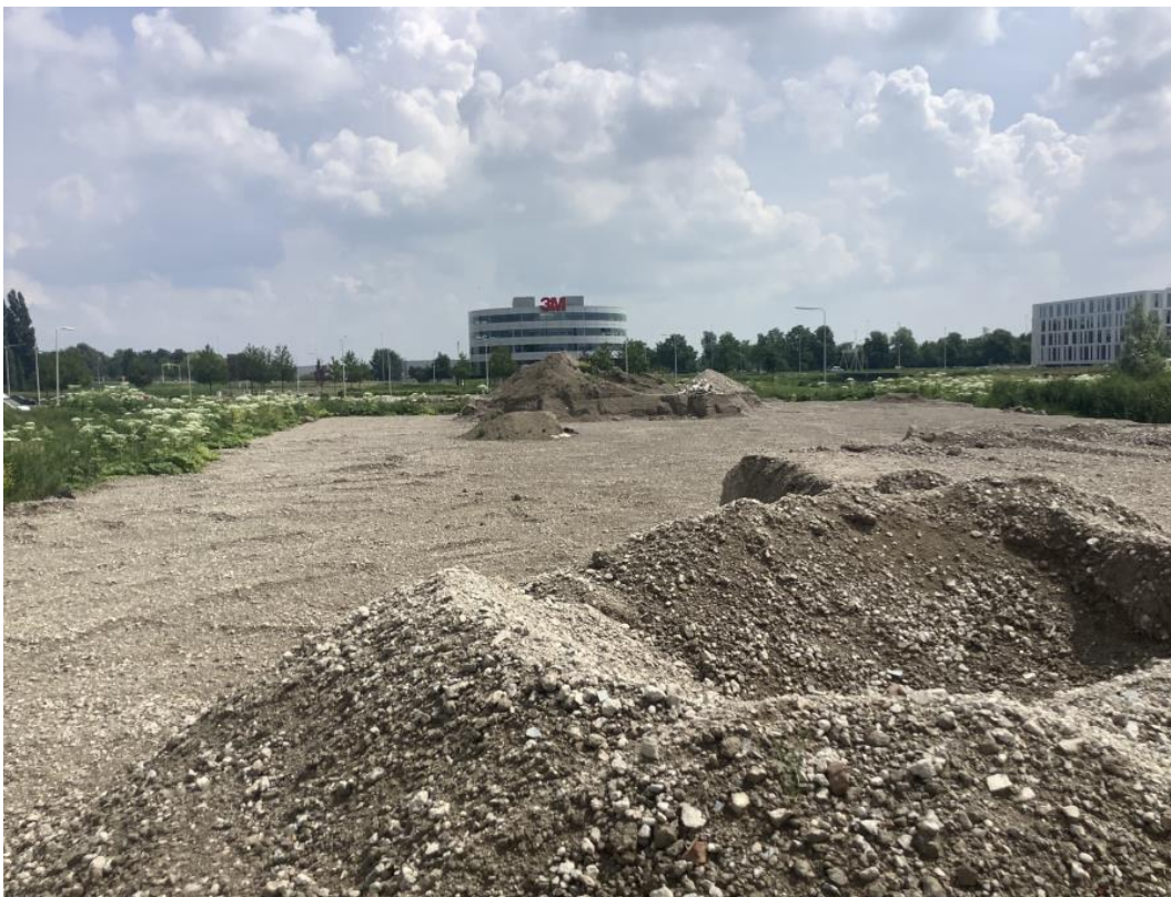
Figuur 4: Cluster 1 verhard oppervlak met puin
