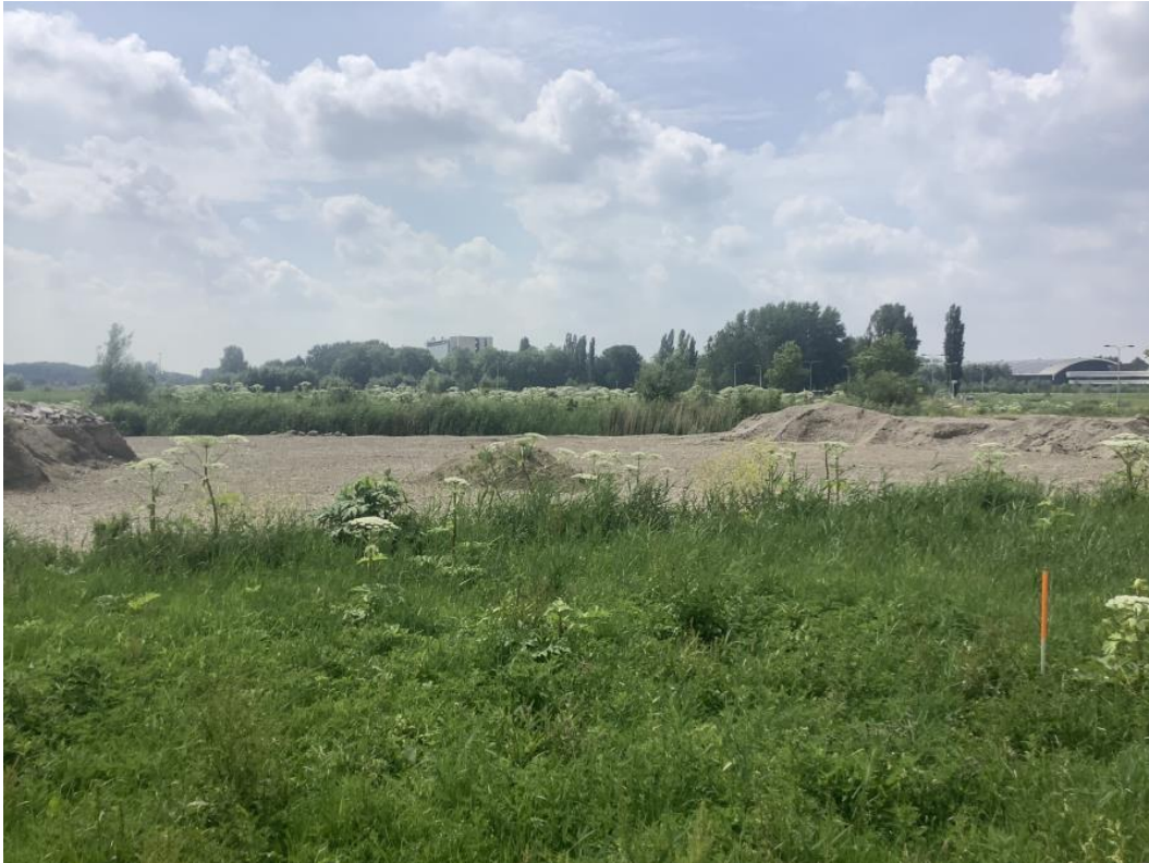
Figuur 3: Cluster 1 verhard oppervlak met puin
