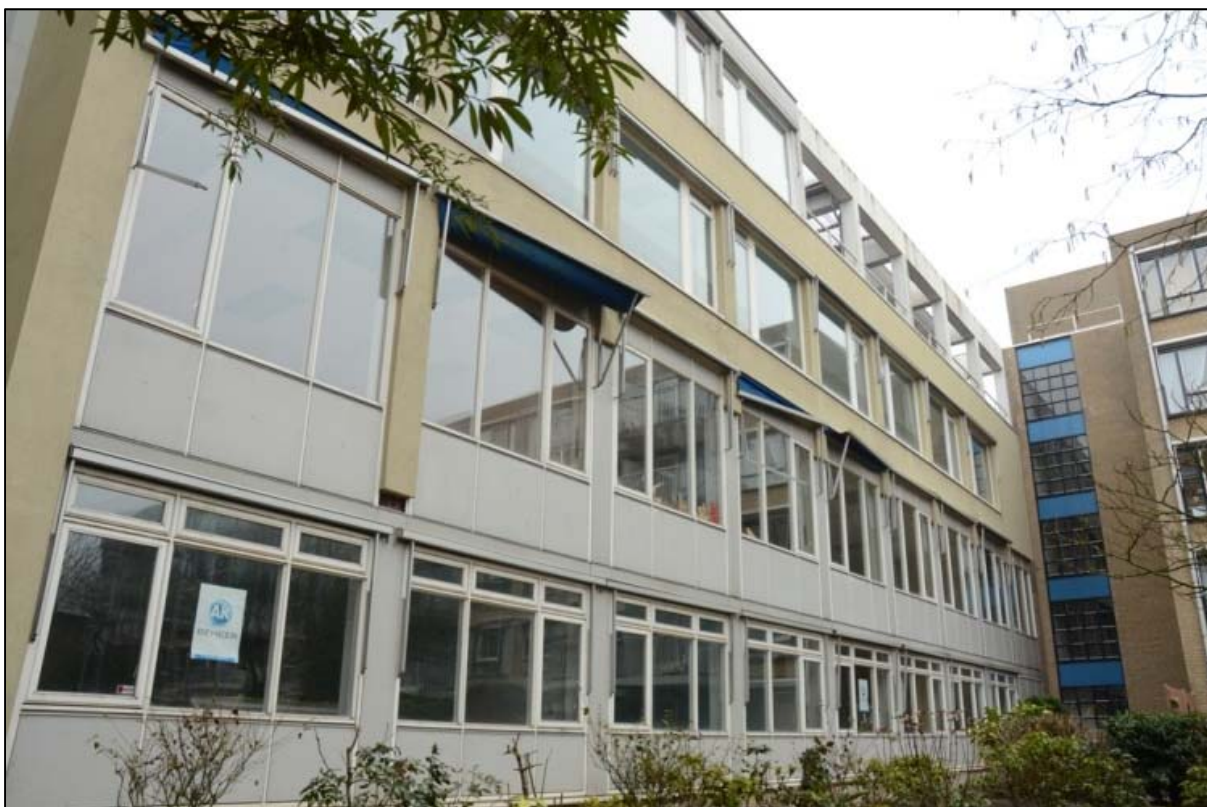
Achterzijde van aanwezige bebouwing in het plangebied.
