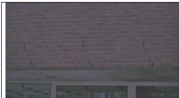
Foto 13: spouwgangen in gebouw Hittech Multin BV
