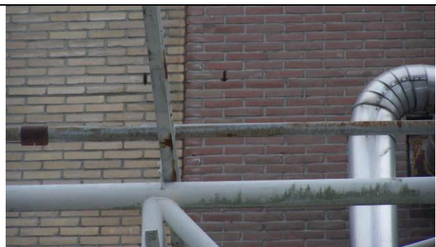
Foto 2: Bakstenen gevels met spouwgangen
