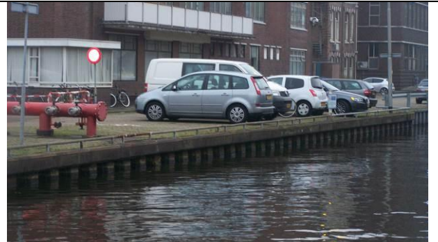
Foto 12: aanleghaven Langs Wateringsevest
