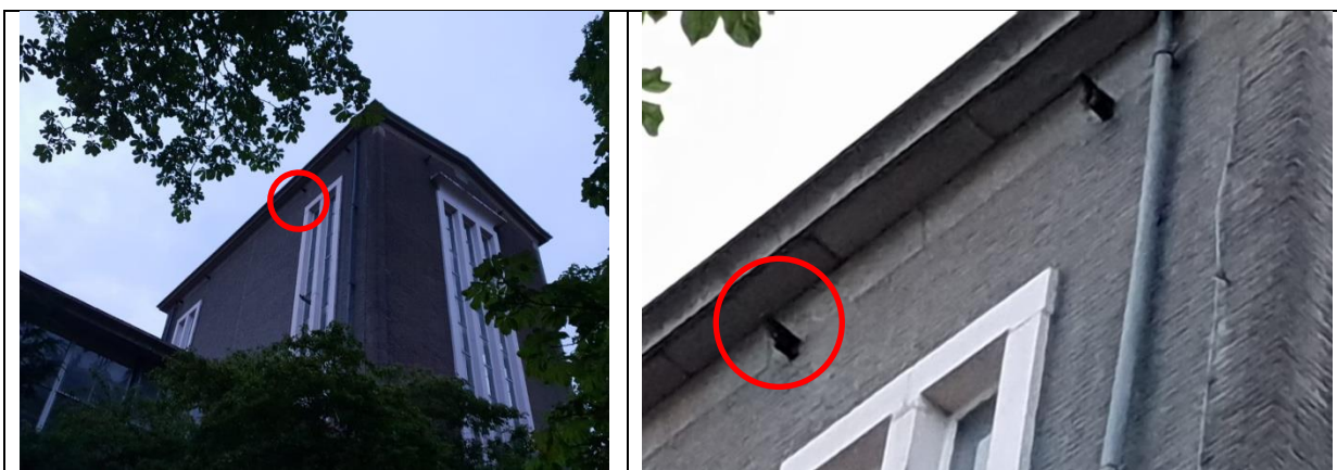
Verblijfplaats 1a. Prins Bernardlaan 6, zuidwestzijde van de toren met detail van de invliegopening (rechts): zwarte pijp bovenaan (tijdens bezoek 'zomeravond Iv').
