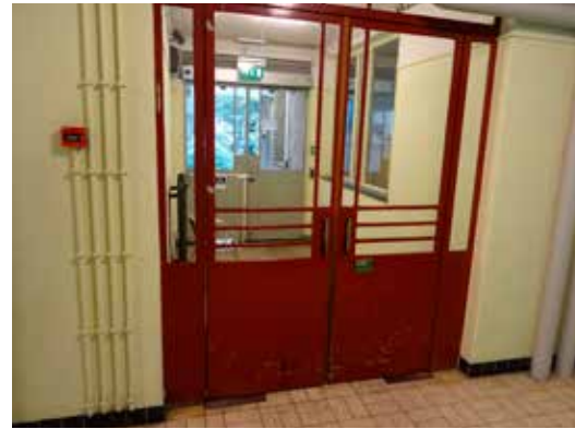
Originele met staal beklede binnendeuren
