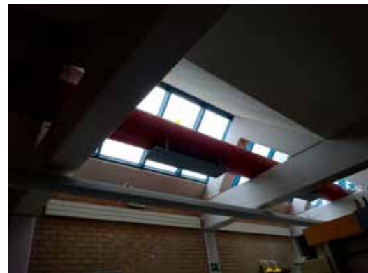
Autoclavenlab in jaren 80 architectuur
