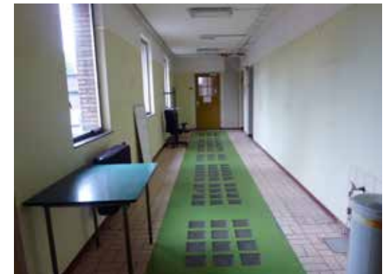
Het daglichtprincipe zichtbaar, indirect licht valt door de glazen tegels naar de gang op de begane grond
