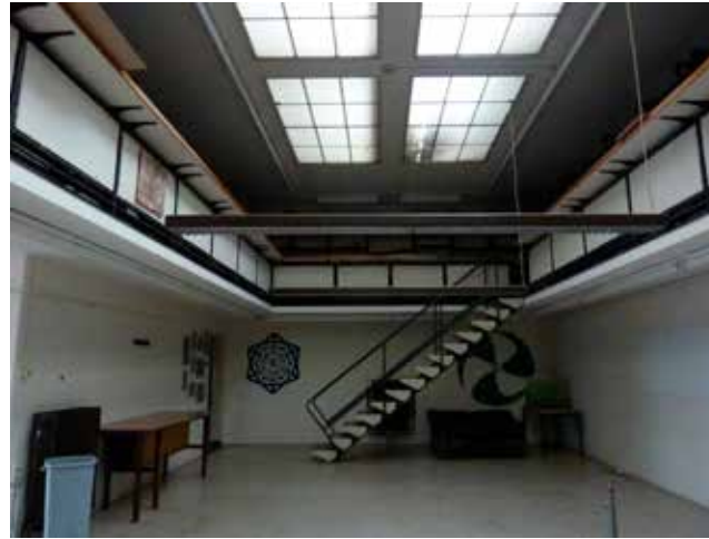
Bibliotheek op de eerste verdieping van de centrale vleugel
