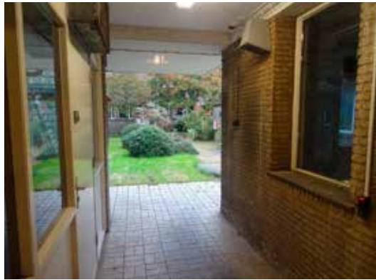
Overgang van buiten naar binnen, aan het einde van de gang in de rechter zijvleugel
