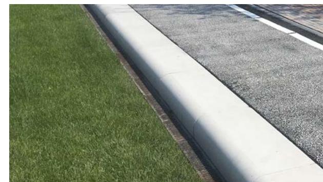
Verdicht beton, kleur licht
