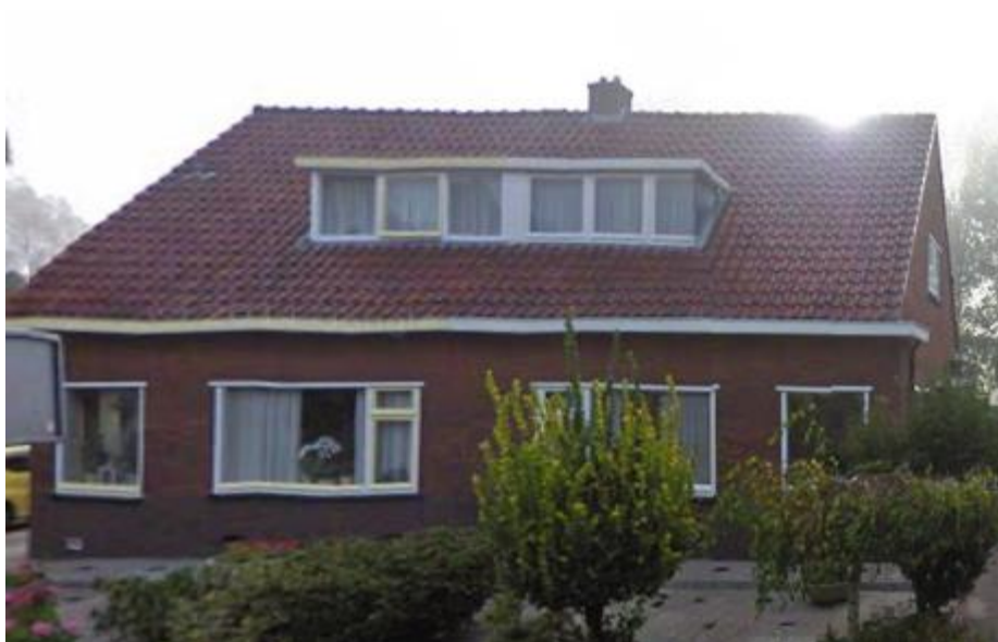
Figuur 4: foto te handhaven bebouwing Bermweg 504 (rechtse woning)
