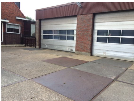
Foto 1: voorzijde loods, vanuit oostelijke richting
