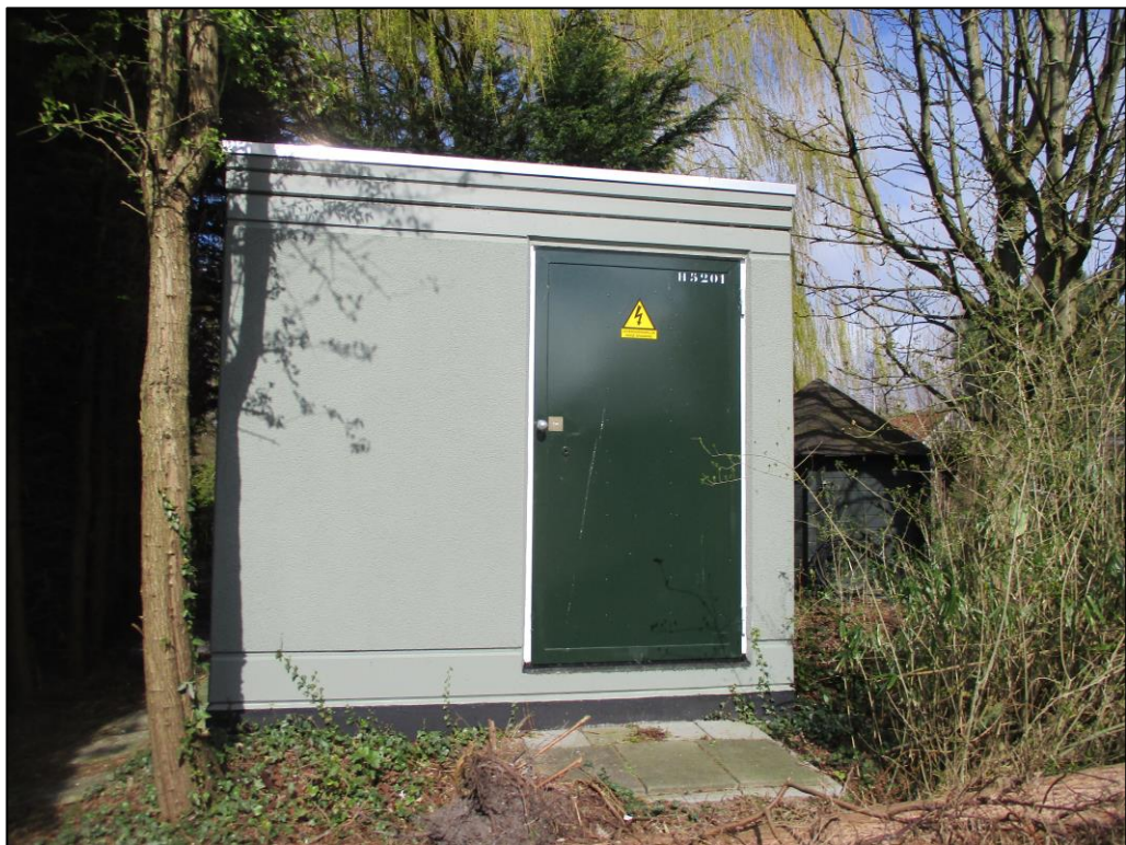
Figuur 4 Het transformatorhuis.
