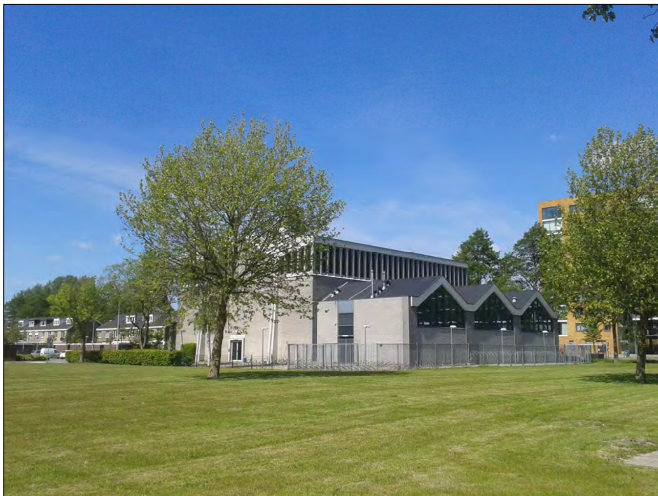
Figuur 2. Zicht op de projectlocatie.
