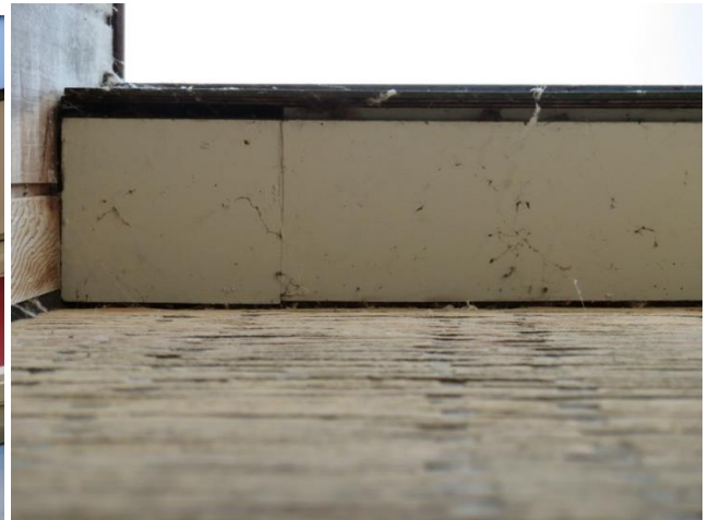
Afbeelding 11: Aansluiting tresa op gevel en houten betimmering.
