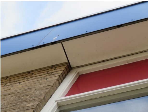
Afbeelding 10: Aansluiting tresa op gevel en kozijn.
