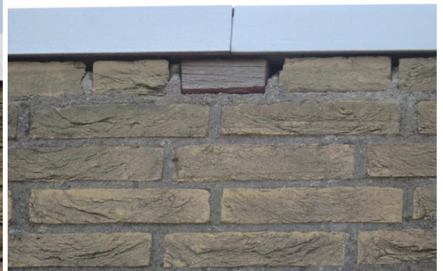
Afbeelding 13: draagbalken dakconstructie. De open stootvoegen onder de daklijst zitten allemaal vol cementresten.
