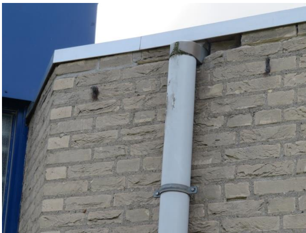
Afbeelding 5: Stukken stof in de open stootvoegen
