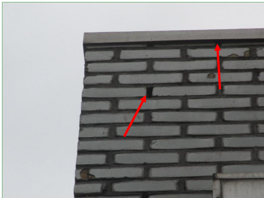
Open stootvoeg en metalen dakrand met mogelijke toegang tot voor vleermuis geschikte achterliggende ruimtes in de bebouwing van de Meeuwensingel 101.
