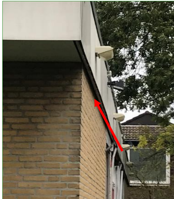
Mogelijke geschikte toegang tot voor vleermuis geschikte achterliggende ruimte in de bebouwing van de Reigerlaan 66.
