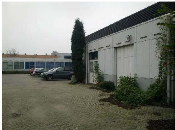
Foto 6: de oostzijde van het plangebied met rechts een uitbouw van de hoogbouw en op de achtergrond de huisartsenpraktijk
