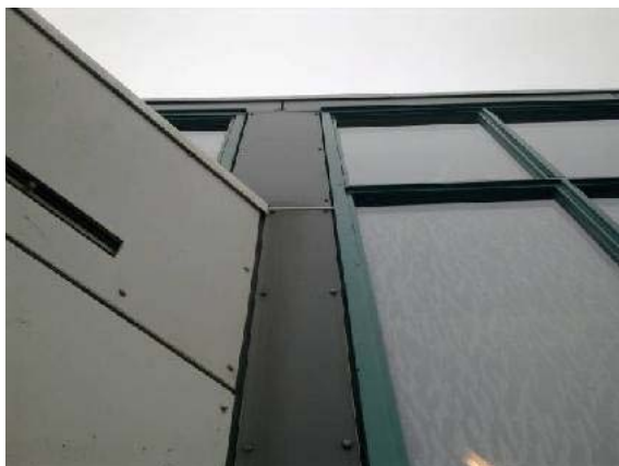
Foto 11: beplating aan de voorzijde bij de ingang; de naden en de daklijst zijn goed afgedicht.
