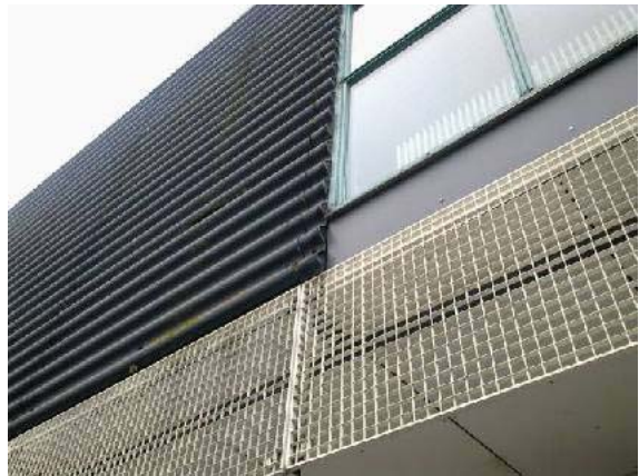
Foto 10: golfbeplating aan de gevel; aan zowel de onderzijde als zijkant goed afgedicht.
